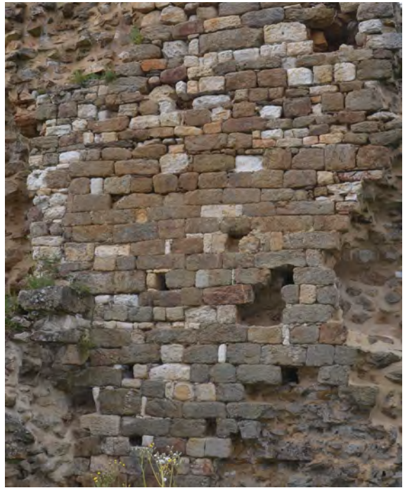
Portion de mur du Château du Guildo présentant du granite (beige) et du gneiss (gris et rouille)
