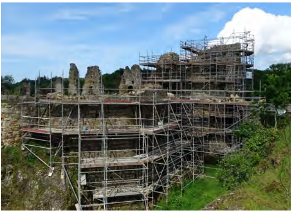
La tour polygonale et le châtelet du château du Guildo échafaudés lors de la première tranche de travaux de conservation et de sécurisation (2017-2018) © Stéphane Berland
