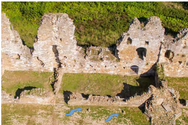
Deux bases de piles en bois qui soutenaient probablement la galerie extérieure © Chimair
